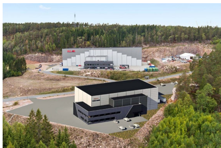
Kombinasjonsbygg i Røyken Næringspark
