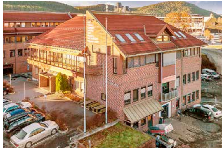
Showroom/butikklokaler med lager og kontorer sentralt i Kongsberg
