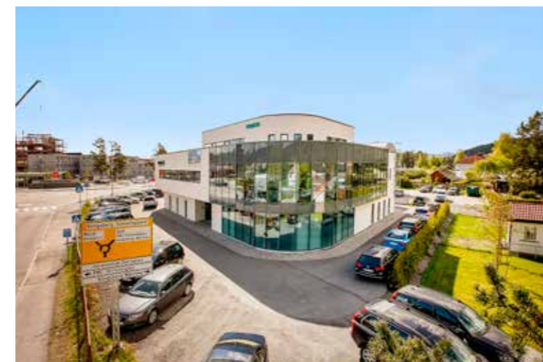
Moderne toppetasje med parkering ved Kongsberg teknologipark
