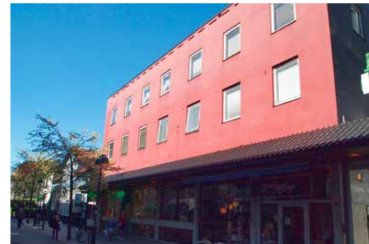
Kontorlokaler i Drammen sentrum
