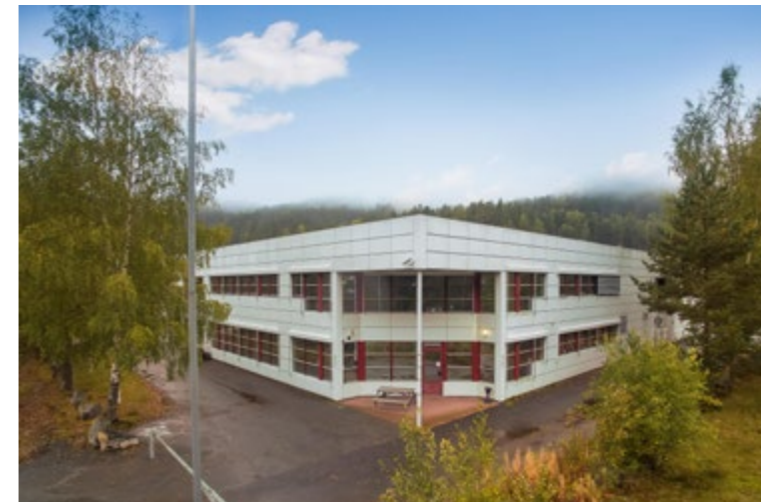
Kombinasjonsbygg på Moane industriområde – lager og kontor
